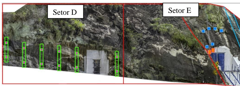
Figura 5. Soluções de engenharia dos setores D e E, no trecho mais à direita da visualização do talude a partir da via, cujo extremo esquerdo é continuação imediata do extremo direito da Figura 4
