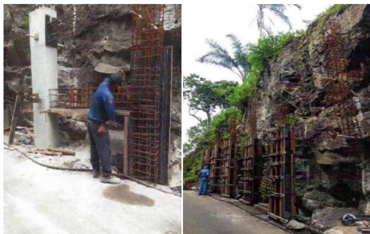
Figura 13 – Implemento da grelha (esquerda) e dos contrafortes atirantados (direita)
