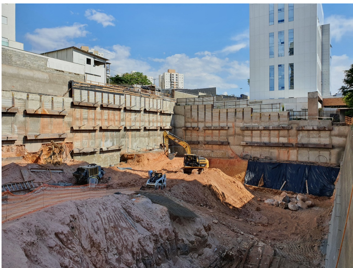
Figura 5.1. Execução das contenções do empreendimento com tirantes provisórios e solo grampeado.
