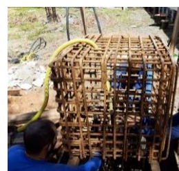
(c) Armação apoiada na fôrma
