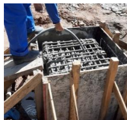
(e) Vibração do concreto
