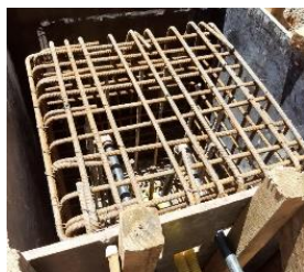
(d) Passagem dos tubos e cabos pela lateral do bloco
