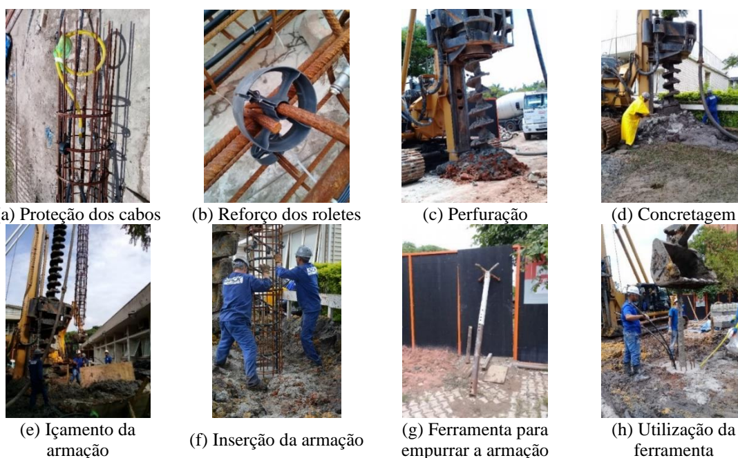
Figura 7. Preparo e execução das estacas.
