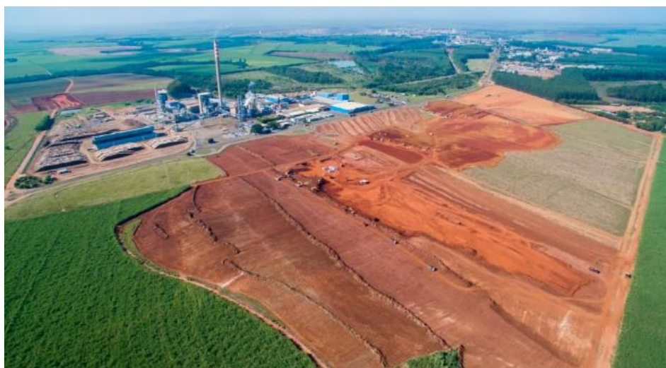
Fotografia 2: Vista do canteiro de obras da fábrica de celulose
