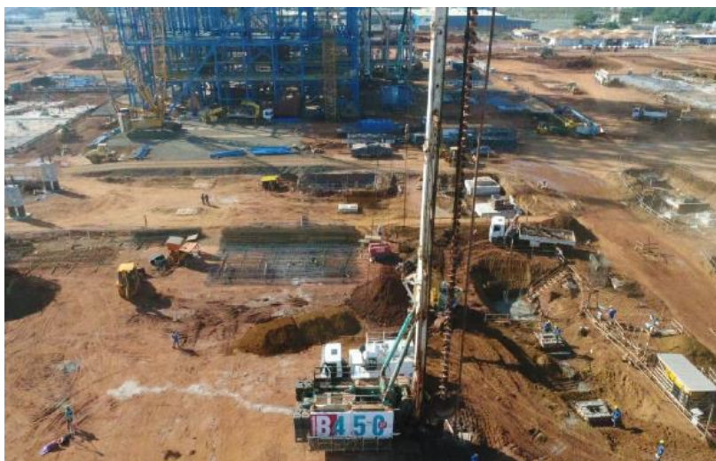
Fotografia 4: Vista da obra em fase de perfuração das estacas///
