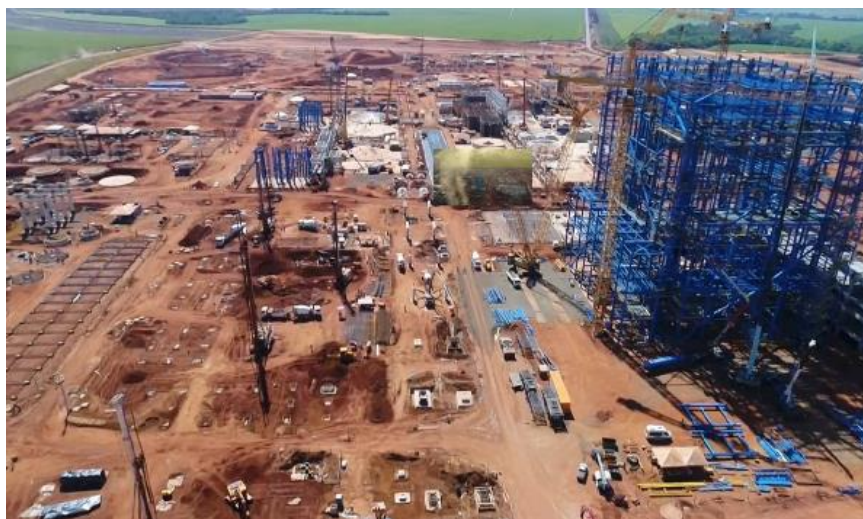
Fotografia 3: Canteiro de obras da fábrica de celulose
