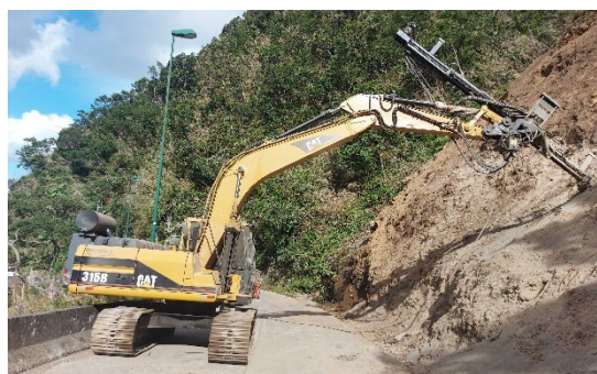
Figura 13: Escavadeira com Perfuratriz acoplada
