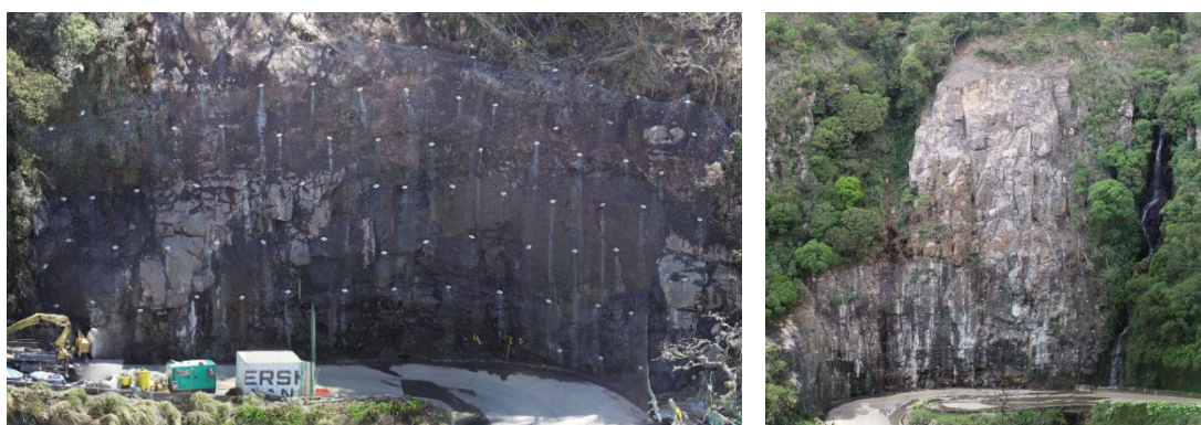
Figura 7: Exemplo de tratamento com estabilização de talude rochoso com (esq.) sistema TECCO no ponto 1 e (dir.) sistema SPIDER e TECCO no ponto 3.
