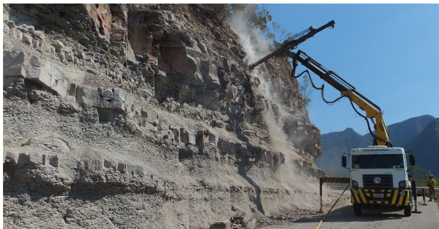
Figura 12: Caminhão Munck com Perfuratriz acoplada
