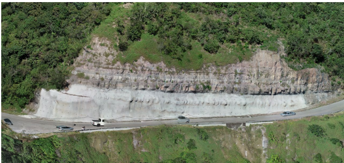
Figura 8: Tratamento com Sistema TECCO, na parte superior do talude; e Concreto Projetado, na parte inferior do talude.
