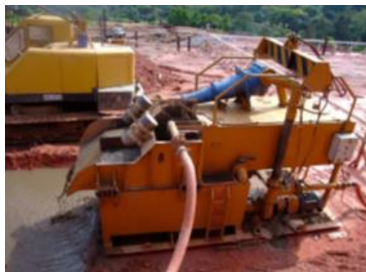
Figura 1 – Vista do Reciclador
