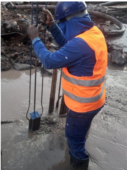
Fotos 3 e 4. Vista do coletor em uso e preenchido com concreto.
