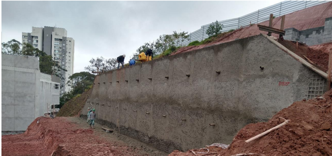
Figura 6. Contenção em solo grampeado – Alinhamento e verticalidade
