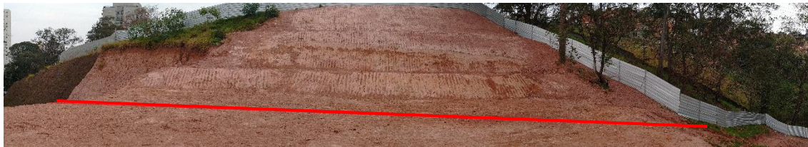
Figura 4. Vista antes do início da contenção – O terreno a montante da contenção foi retaludado - A linha vermelha representa o alinhamento da contenção em solo grampeado
