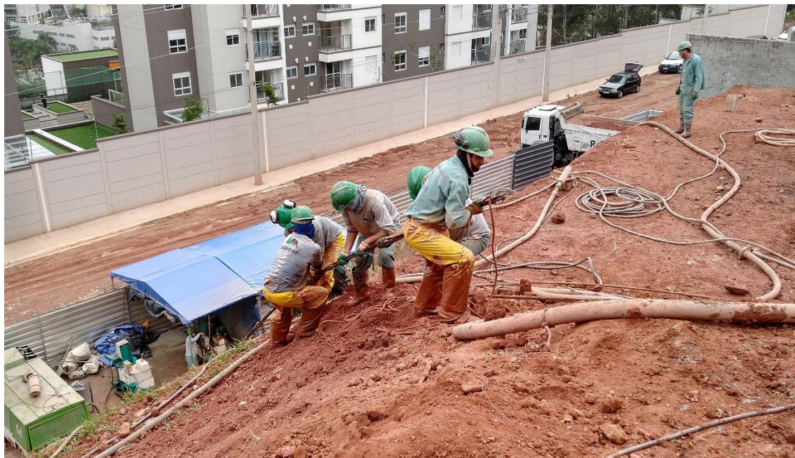
Figura 3. Transporte do grampo montado para o local de instalação
