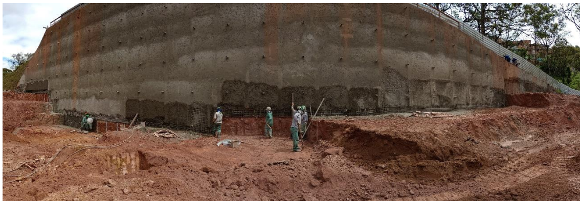
Figura 7. Contenção em solo grampeado – Abertura de nichos, acerto manual e acabamento sarrafeado
