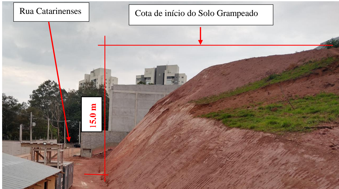
Figura 2. Configuração do terreno antes do início do solo grampeado
