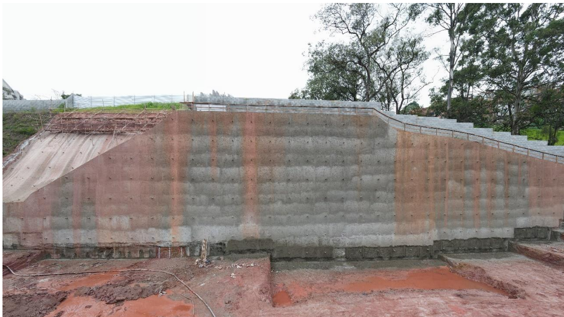
Figura 9. Contenção em solo grampeado em andamento
