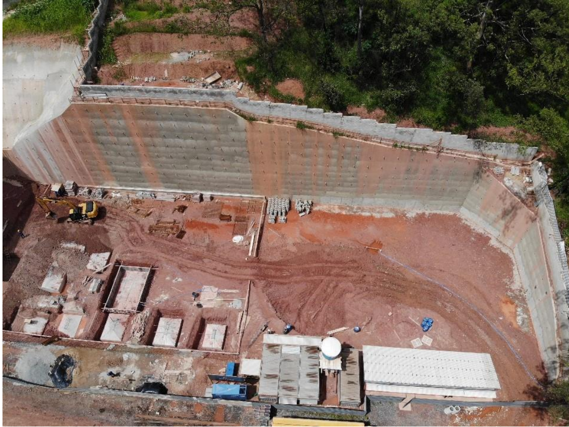
Figura 10. Vista aérea da contenção em solo grampeado concluída
