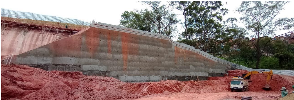
Figura 8. Contenção em solo grampeado – Execução de mestras e concreto projetado
