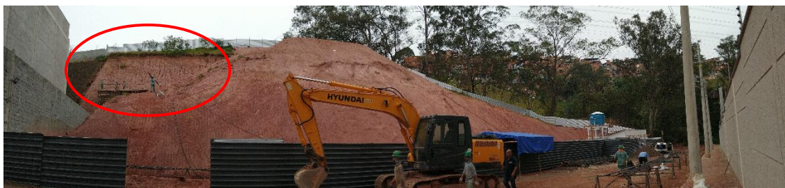
Figura 1. Vista geral do terreno, antes do início da contenção – Talude com inclinação superior a 45°
