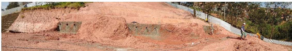
Figura 5. Início da contenção em solo grampeado – primeiros nichos abertos
