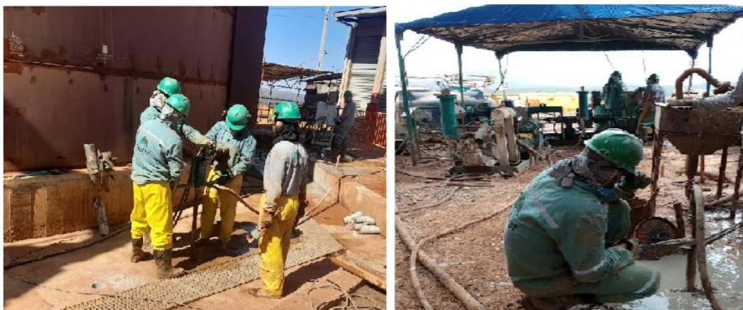
Figura 5. Perfuração e injeção de consolidação em um furo vertical
