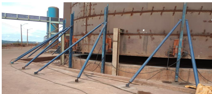
Figura 12. Elevação do tanque sendo realizada através dos macacos hidráulicos.
