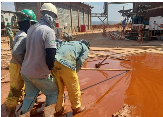
Figura 8. Perfuração para injeção sub-horizantal
