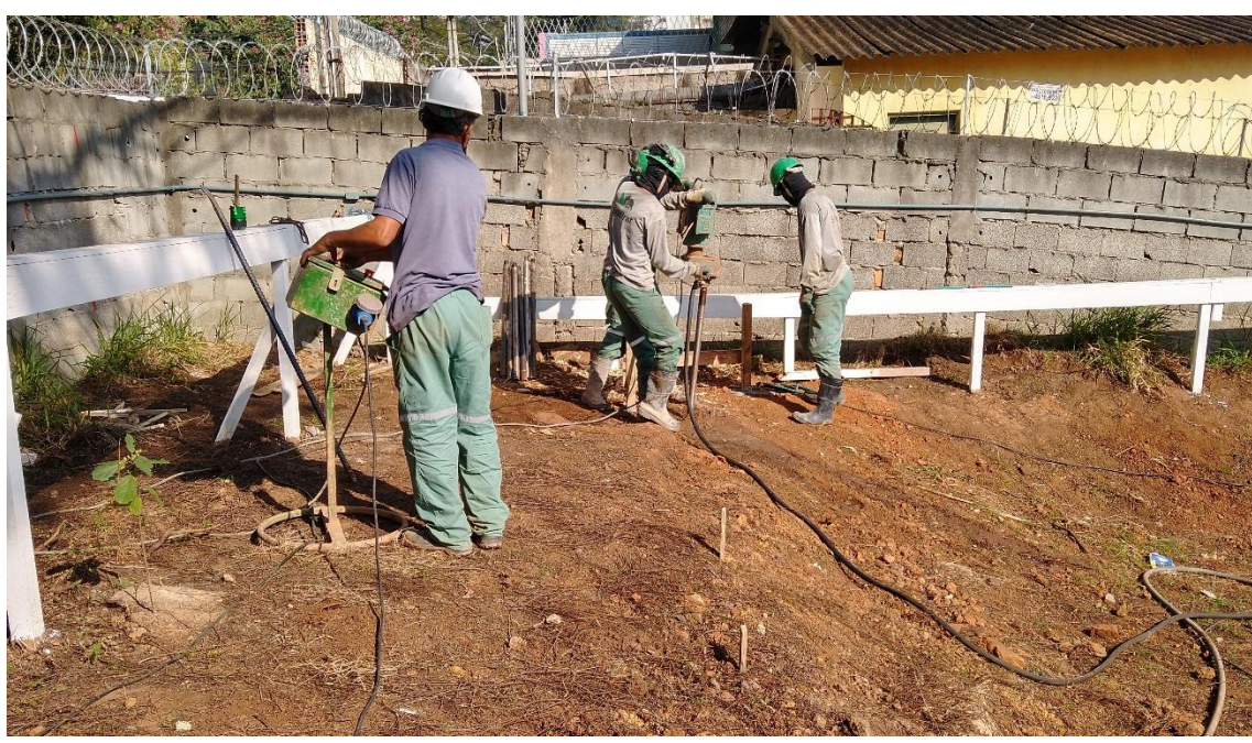
Figura 2. Perfuração de grampos verticais
