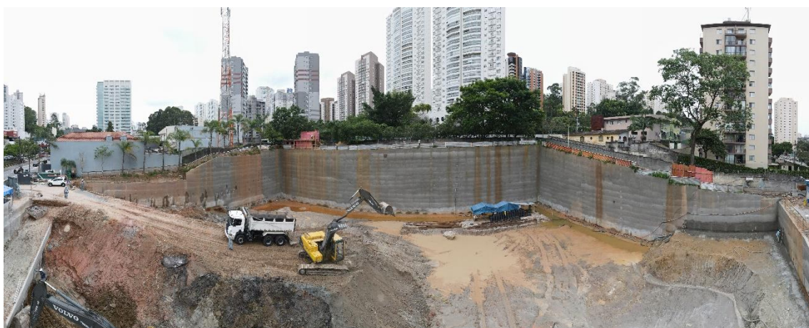
Figura 11. Vista geral da obra
