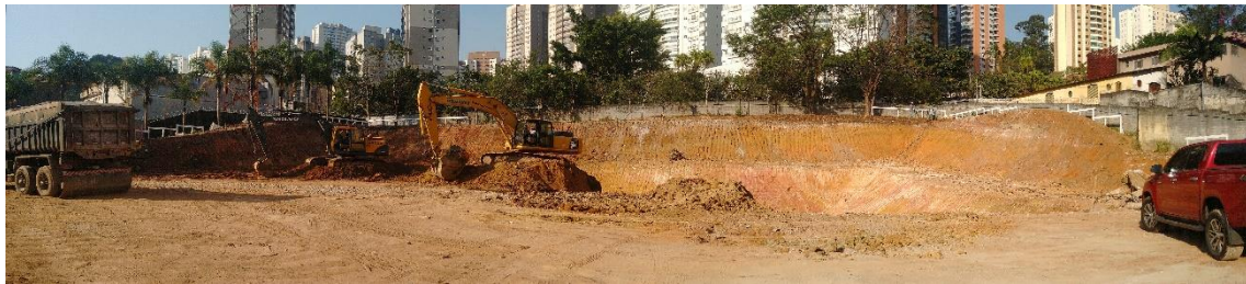
Figura 1. Vista do terreno, antes do início da contenção – escavação do centro do terreno
