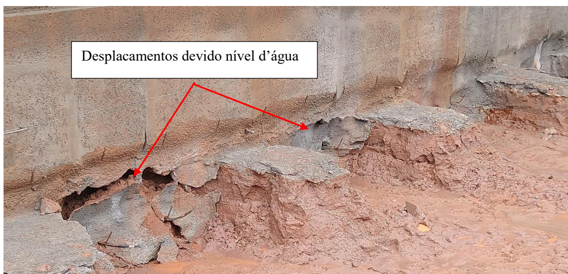
Figura 6. Deslocamentos ocorridos durante a execução do solo grampeado na Vista 1
