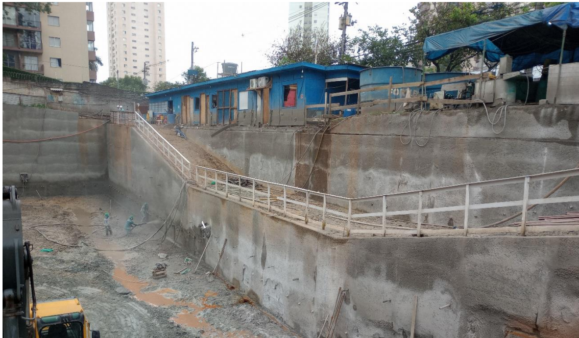
Figura 10. Vistas 4 e 5 – paralelas a Av. Giovanni Gronchi – futura rampa de acesso ao 1º subsolo do edifício
