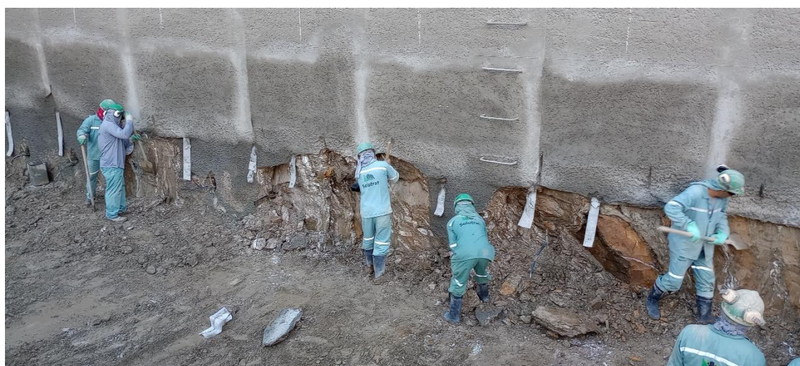
Figura 7. Deslocamentos ocorridos durante a execução do solo grampeado na Vista 2
